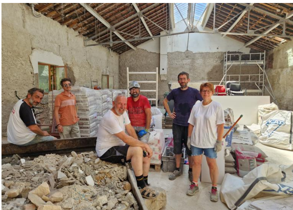
Le chantier participatif de l'Exprimerie réhabilite l'ancienne imprimerie en tiers-lieu culturel. Photo Clémence Outteryck
